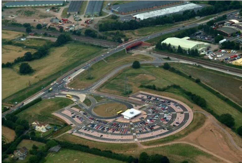
Rysunek Z2-25: Parking P+R przy wjeździe do Taunton w hrabstwie Somerset (Anglia). Na zdjęciu widoczna pętla autobusowa zlokalizowana w obrębie parkingu (źródło: www.movingsomersetforward.co.uk )
