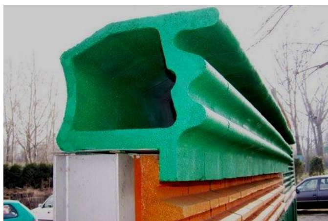
Rysunek Z2-20: Dyfraktor zamontowany na krawędzi górnej ekranu akustycznego (źródło: www.techbud.com.pl ).
