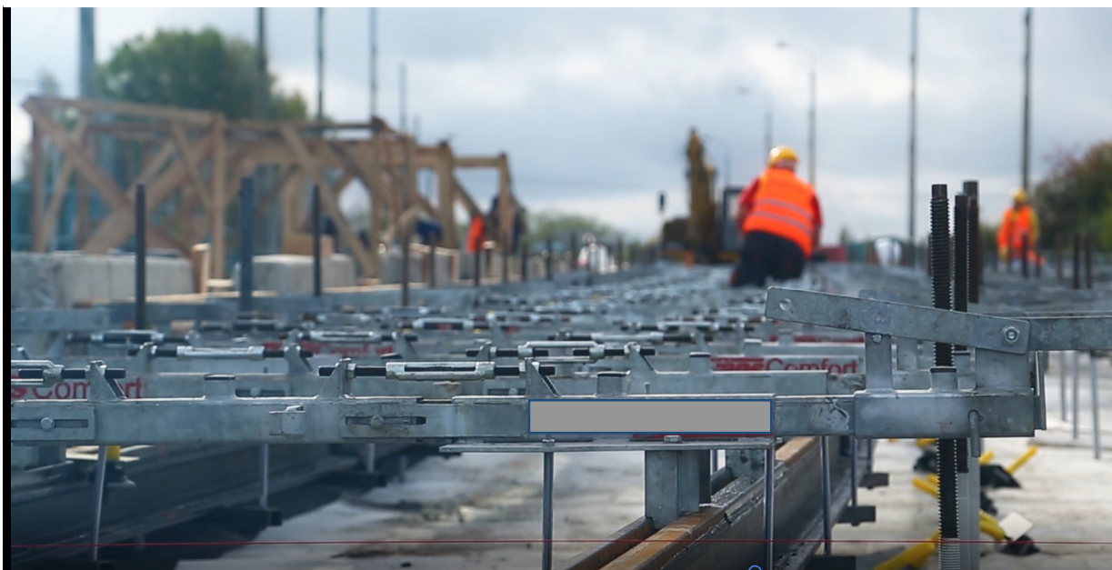
Fot. 1 – montaż torowiska przed betonowaniem za pomocą tzw. bramek roboczych
