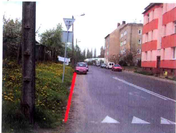
Zdjęcie nr 3.a, b. Odcinek krawędzi ul. Grzywińskiej wymagający oczyszczenia.
