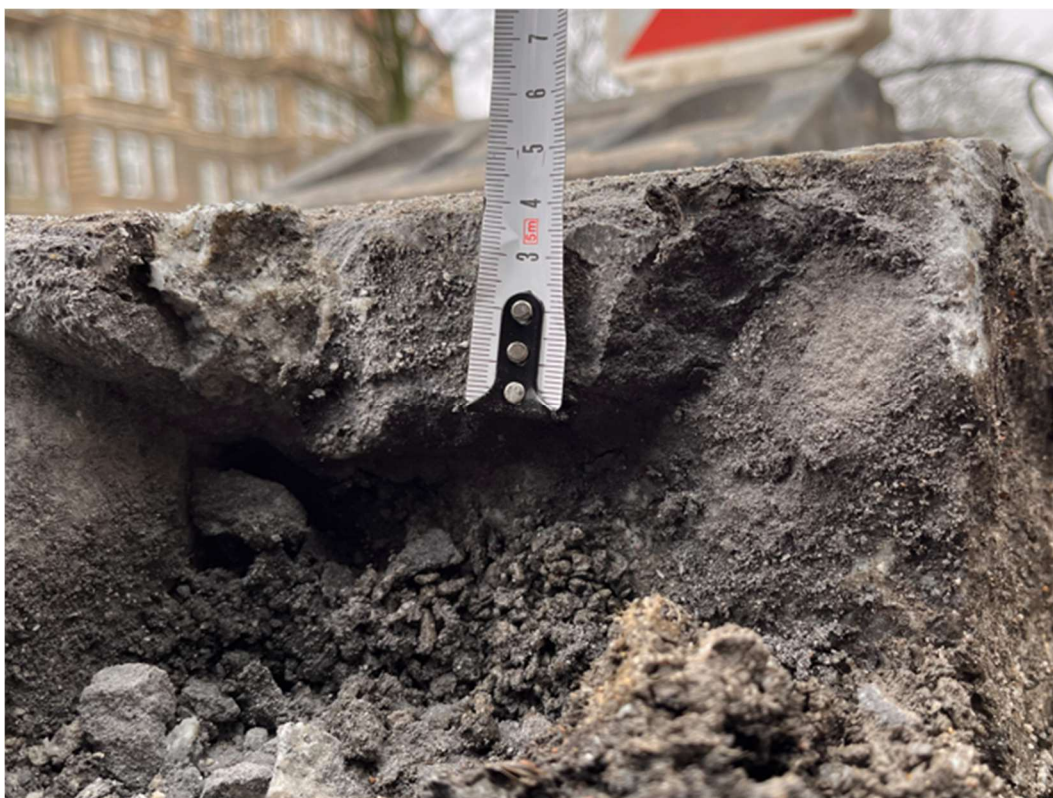
Fot. 7. Przykładowa grubość spoiny
