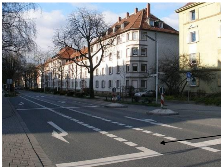
Rysunek Z2-31: Wydzielony pas dla ruchu rowerów. Rower nie koliduje ze skręcającymi w prawo – Darmstadt (Niemcy) (źródło: materiały własne).
