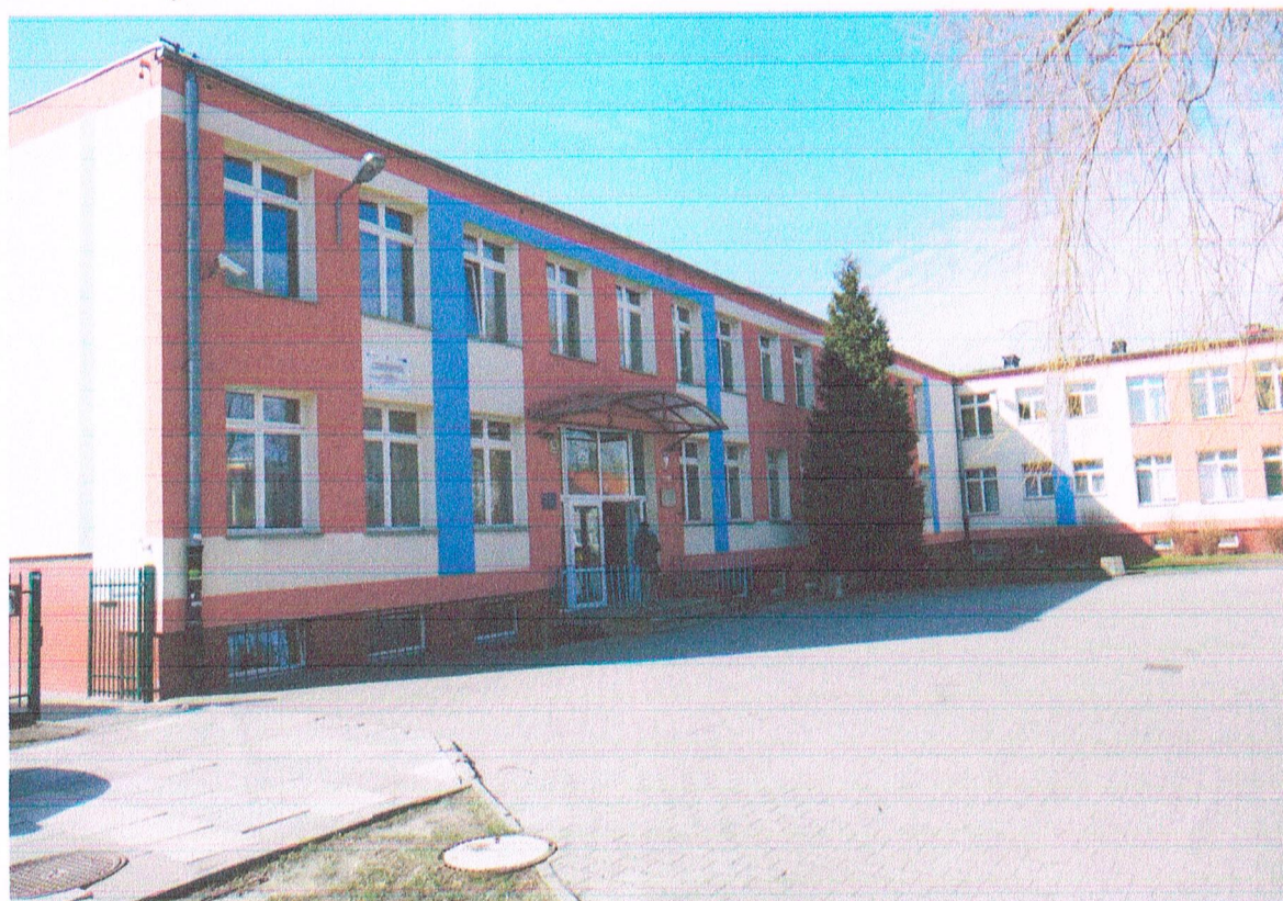
Fot. nr 4 Wejście główne
