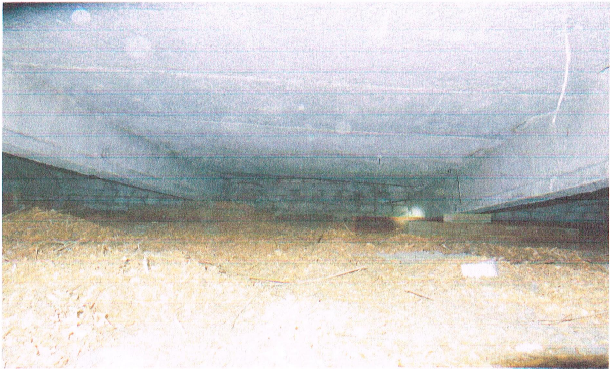
Fot. nr 5. Belki podparte po stronie zachodniej stropodachu
