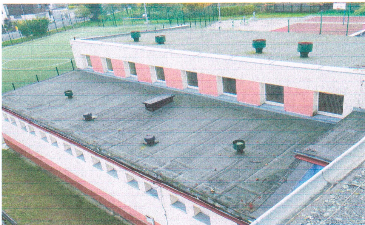
Fota nr 11 Dach sali gimnastycznej
