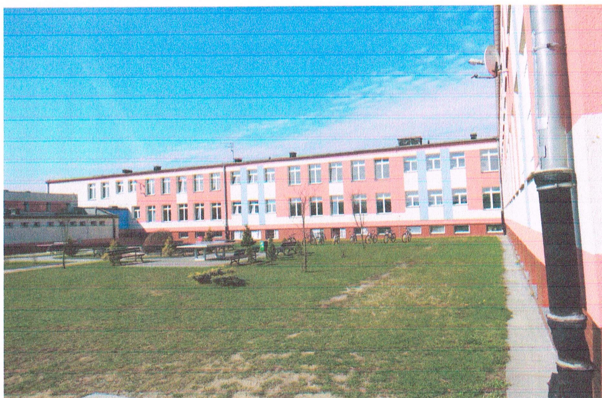
Fot. nr 3 Elewacja wschodnia
