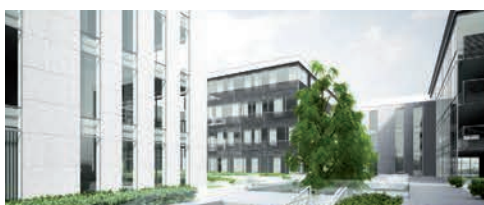
Szczecin Business Plaza (w budowie)
