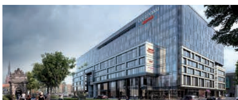
Posejdon Office (w budowie)
