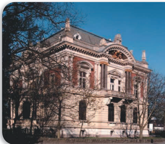
Nowa siedziba Pałacu Młodzieży
