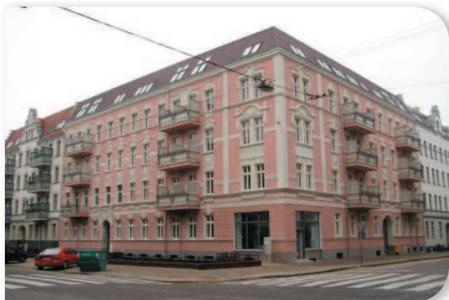
Rewitalizacja kwartału nr 27 – kamienica przy ul. B. Śmiałego 12
