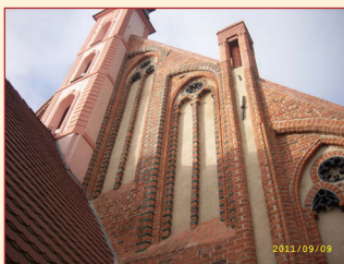
15. Elewacja wschodnia korpusu nawowego po konserwacji
