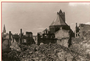
22. Lata 1953–1955, prace zabezpieczające, wykonanie sklepienia nad chórem
