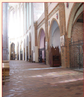
30. Obejście chóru z nową posadzką
