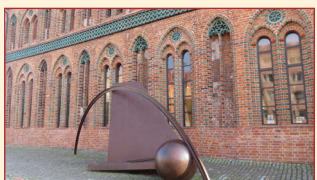
45. Gotyckie okna ratusza odsłonięte podczas powojennej odbudowy
