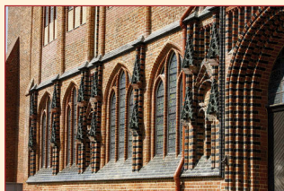
23. Dekoracja maswerkowa elewacji południowej po konserwacji
