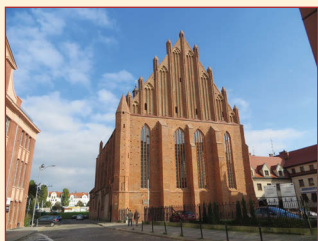
17. Fasada zachodnia po konserwacji
