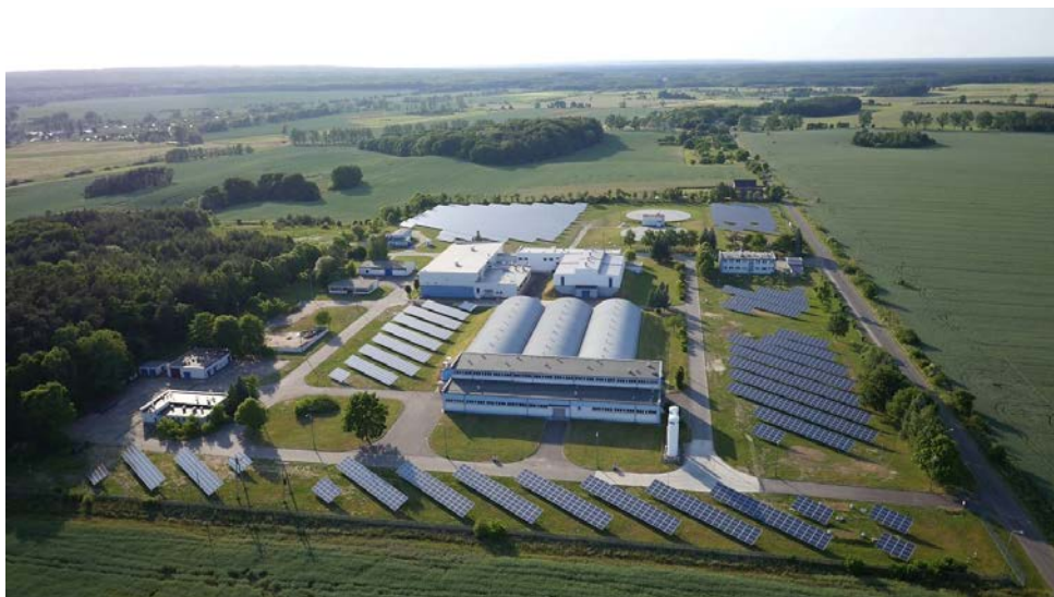
Farma fotowoltaiczna ZPW Miedwie (Fot. Zarząd Wodociągów i Kanalizacji Sp. z o.o. w Szczecinie)
