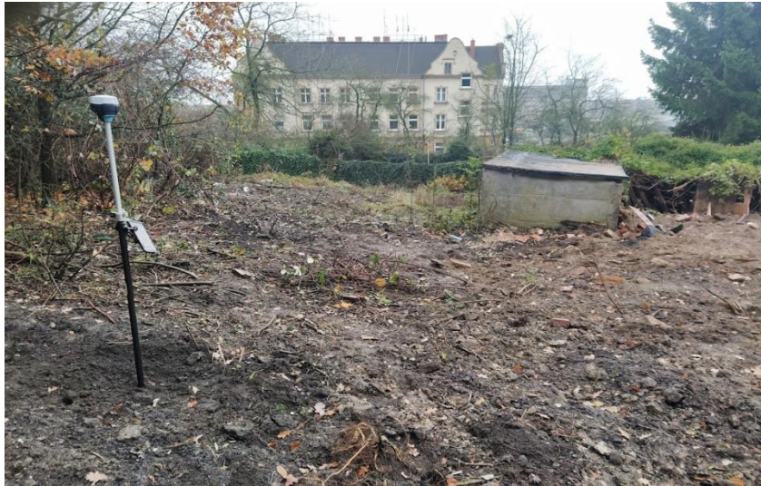
Lokalizacja zniszczonego punktu s02_13 na osuwisku nr.2, w miejscu tyczki GNSS. Teren przygotowywany pod inwestycję budowlaną (?)
