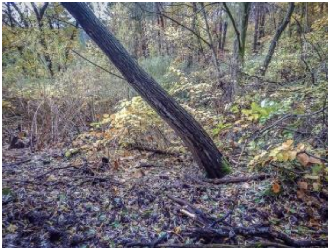
Fot. 2. Wyphywy i wysięki w dolnej części osuwiska.
