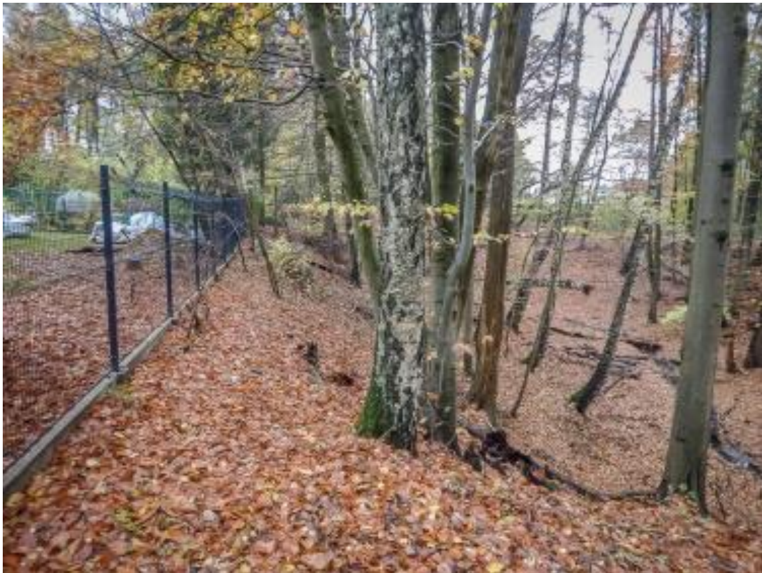
Fot. 3. Górna krawędź osuwiska dochodząca do ogrodzenia.
