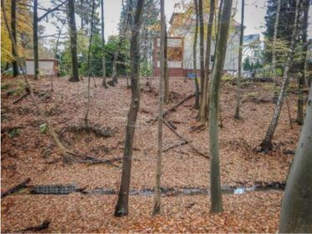
Fot. 4. Widok zachodniej części osuwiska sąsiadującej z budynkiem mieszkalnym.
