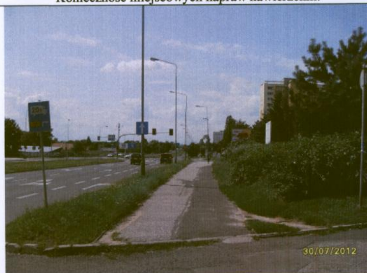
Szerokość chodnika 3.0. Konieczność poszerzenia chodnika i obniżenia krawężników.
