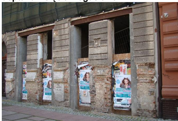
Fot. 7. Niezagospodarowany budynek przy deptaku Księcia Bogusława X
