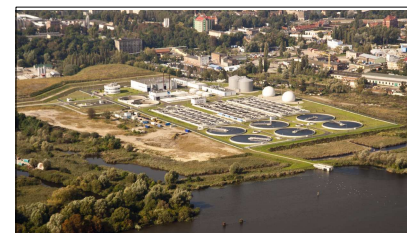
2. Oczyszczalnia ścieków Pomorzany
