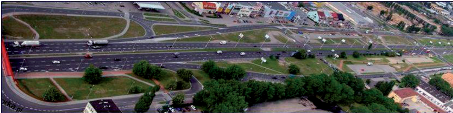
Modernizacja dostępu drogowego do portu w Szczecinie
