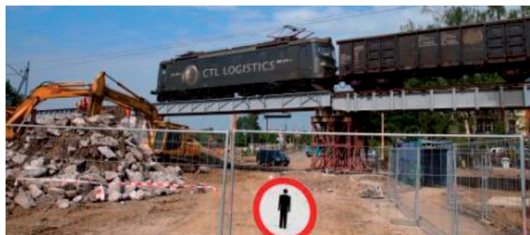
Budowa obwodnicy Śródmieścia
