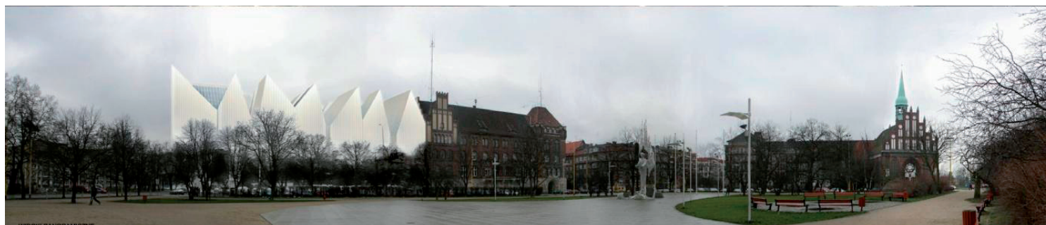
Budowa Filharmonii Szczecińskiej
