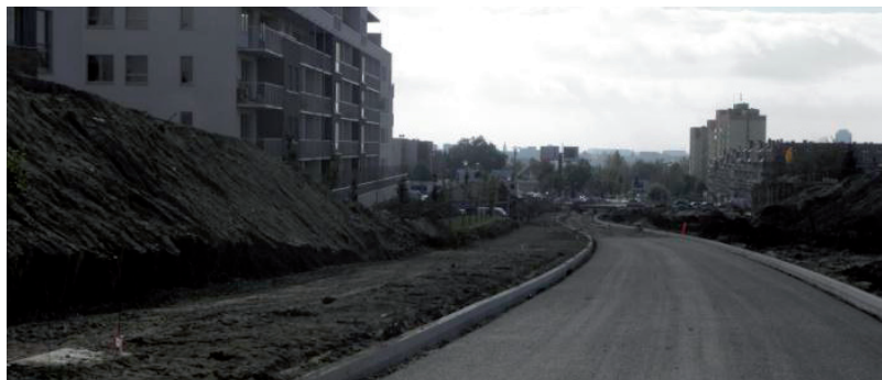
Budowa Trasy Północnej
