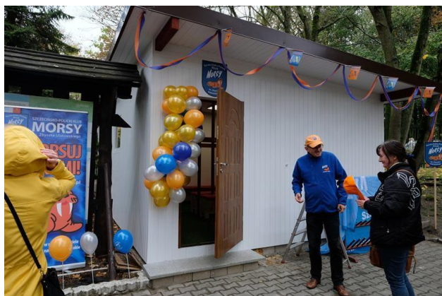
Fot. Budowa magazynka-przebieralni dla osób morsujących nad Jeziorem Głębokie
