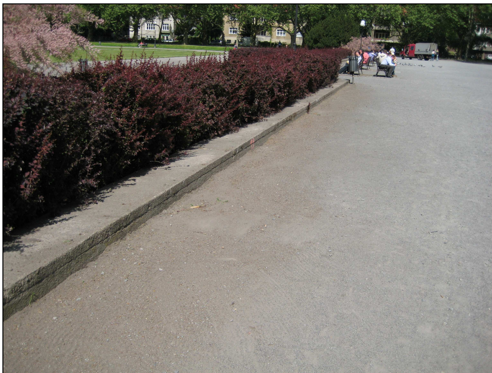
Fot. 1 – Nawierzchnia żwirowa istniejąca.
