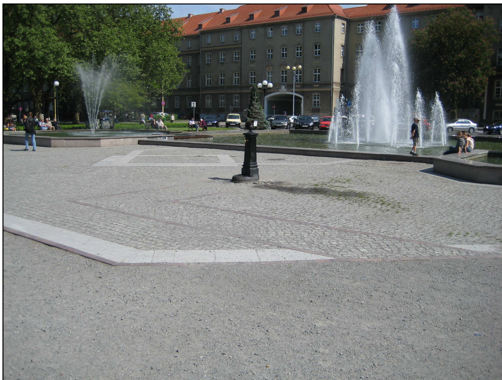
Fot. 3 – Nawierzchnia placu przy fontannie.
