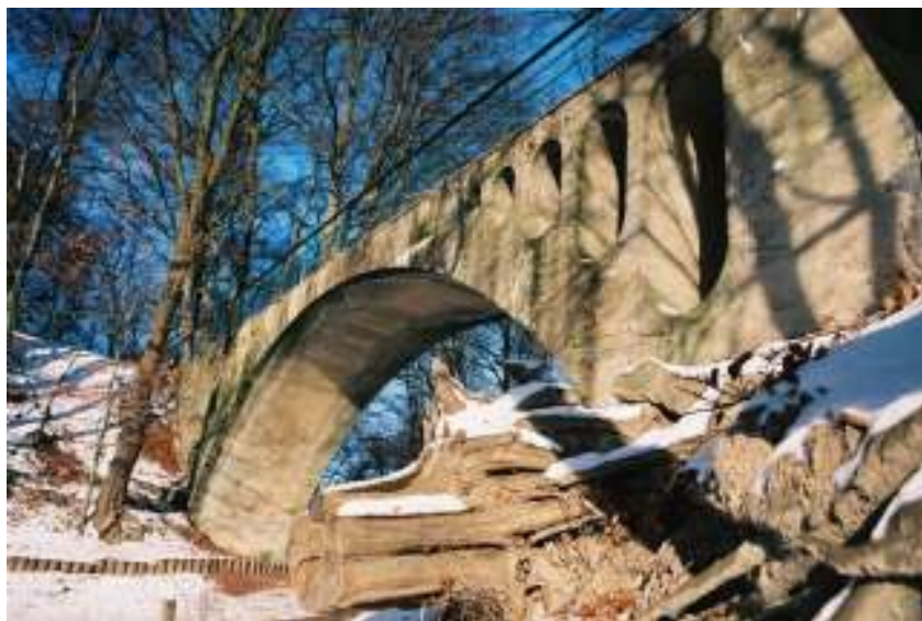
Mostek betonowy przy Jeziorze Szmaragdowym
